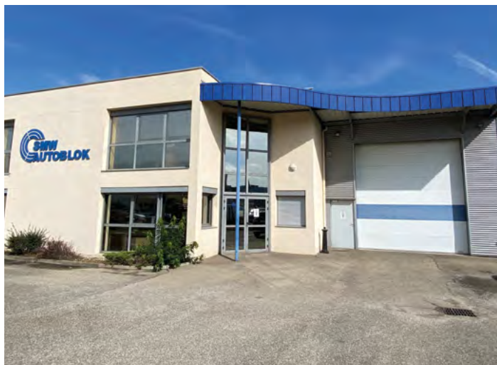
Siège SMW-AUTOBLOK France, Lyon. Administrations, ventes, bureau d'études et support technique
